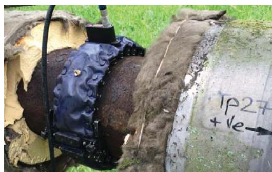
Fot. 4b Badanie diagnostyczne z wykorzystaniem metody ultradźwięków dalekiego zasięgu LRUT Dn 350
