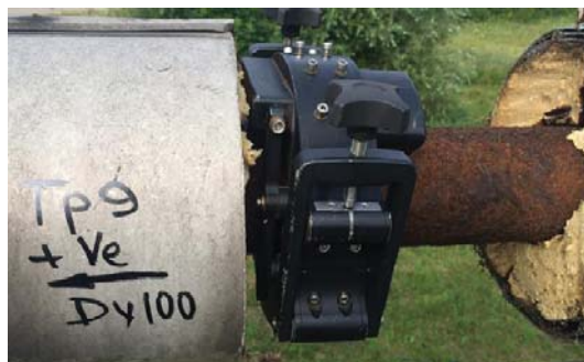
Fot. 4a Badanie diagnostyczne z wykorzystaniem metody ultradźwięków dalekiego zasięgu rurociąg Dn 100
